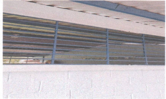
Foto 2: Se han sustituido las ventanas por los balcones para mayor seguridad y ambiente (Módulos 1 y 2)
