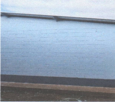
Foto 1: Se ha finalizado con el trabajo de pintura de la escuela (Módulos 1,2 y 3)
