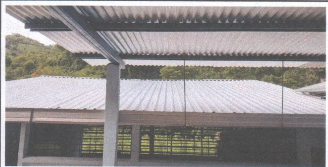
Foto 6: Se ha sustituido la cubierta de lamina (Modulo 1,2 y 3)
